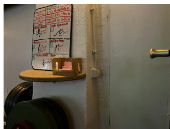
De schakelaar bij platform 8 wel/niet omzetten - aan de andere kant idem voor 6-7 - bij platform 8 staat ook een extra luchtkoeler en hangt rechtsboven nog een stekkerdoos.
